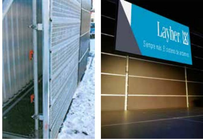
**Perfil vertical para cerramientos 2.** Mediante la utilización del perfil junto con plataformas estándar se consigue cerrar el andamio para así evitar los accesos no deseados.
